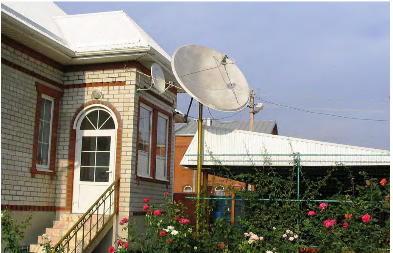
Пример выполненных работ с моторизированной антенной 2,0 метра на частном доме.
